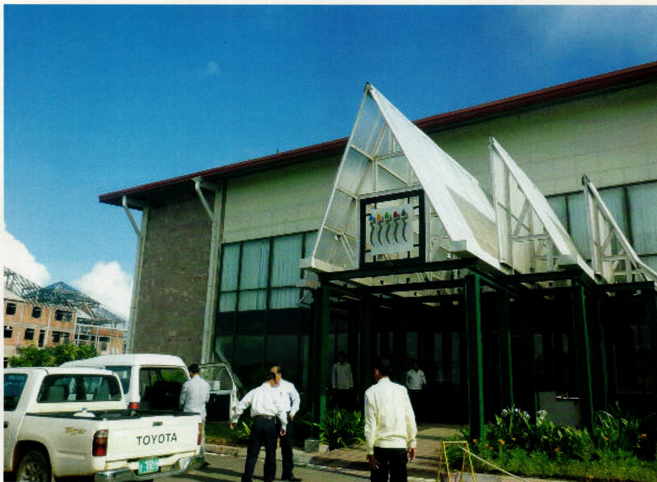
アンコール遺跡整備公団本部通用口
