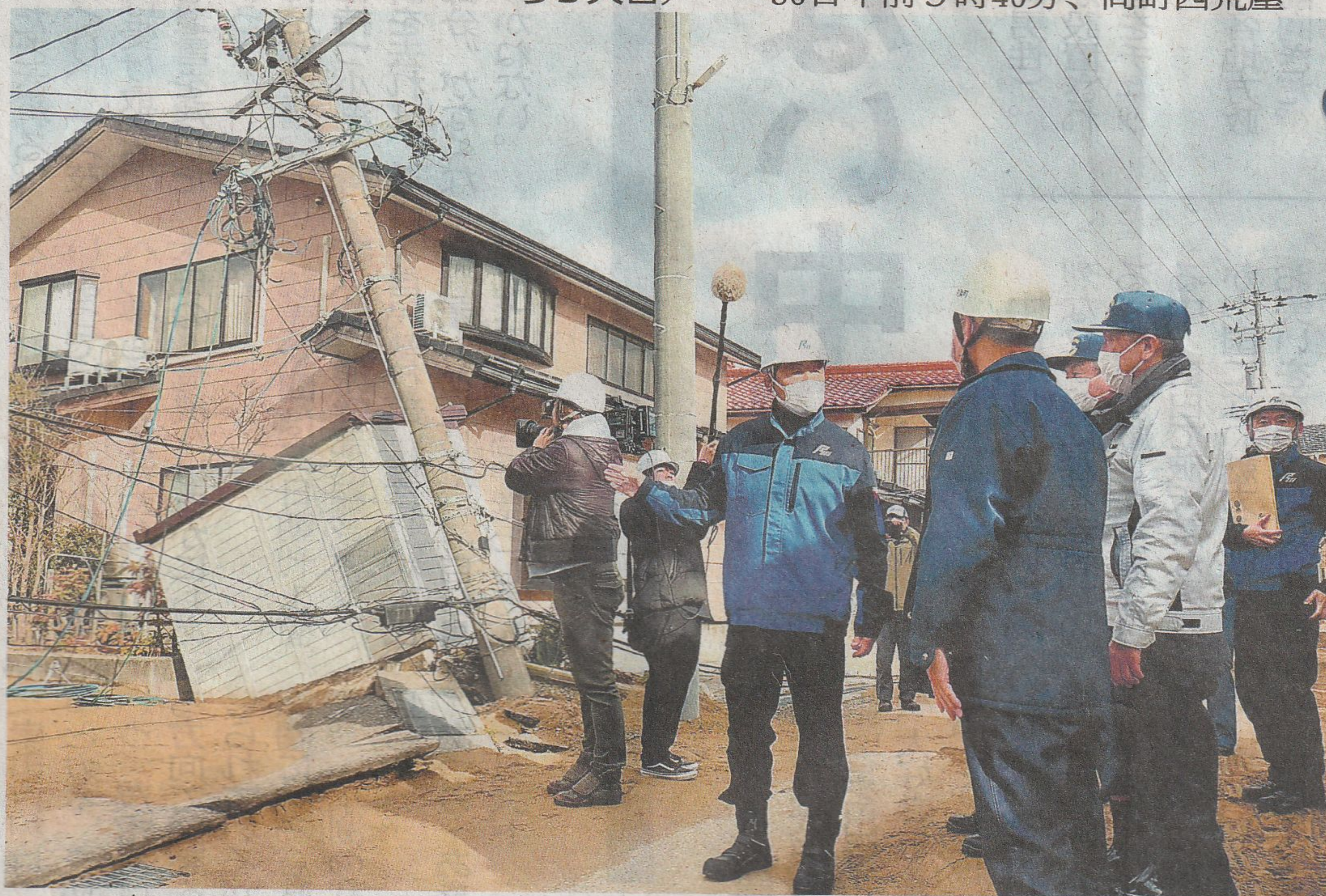
内灘町の液状化の被害を視察する馳知事(左から3人目) —30日午前9時40分、同町西荒屋
