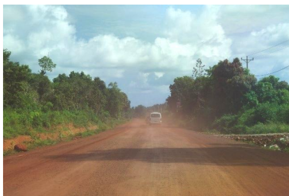
写真3. 郊外でみられた未舗装の道路
