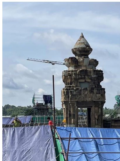
写真3. 修復中のメボン.
