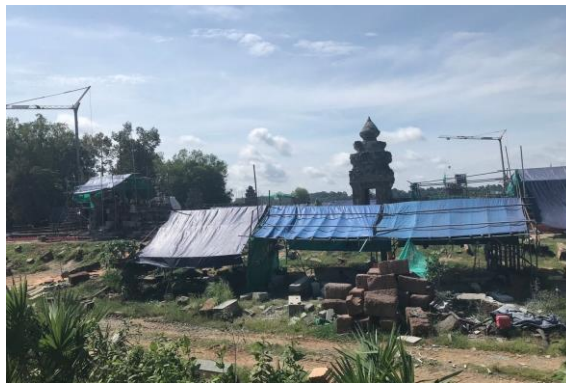
写真3. 修復工事中のメボン.
